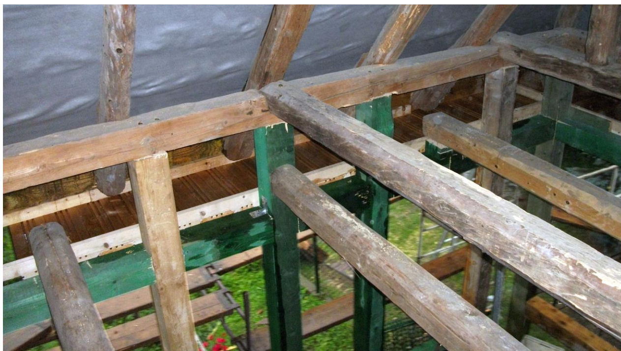
Widoczne belki, rozmieszczone na dwóch poziomach wyrysowują sporych rozmiarów przestrzeń schowka. Od góry, maskowała go podłoga stryszka, od dołu deskowanie sufitu werandy (zdemontowano je w czasie remontu). (Fot: R. Solecki)
